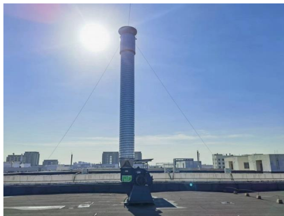
D4 厂房排气筒
