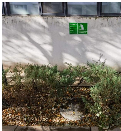
D7 厂房污水总排口
