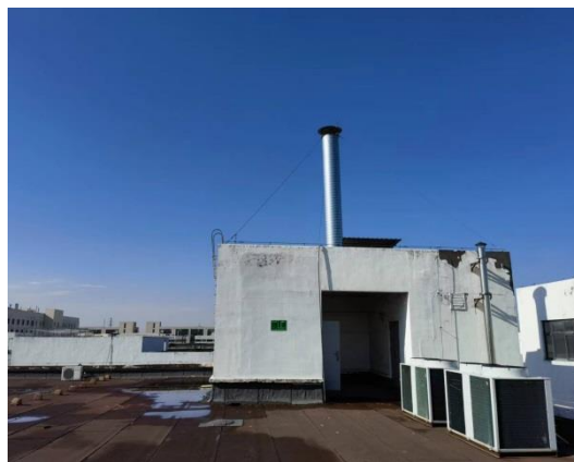
D7 厂房排气筒
