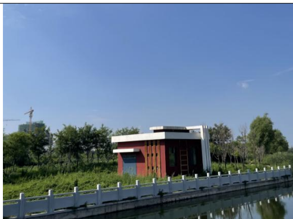
图 4-5 水闸工程北侧中控室现状图
