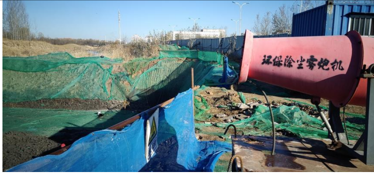
图 7-1 施工期现场洒水抑尘照片
