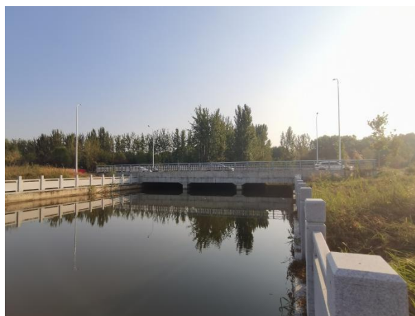
图 4-4 景观桥梁现状图（水闸位于桥下方）
