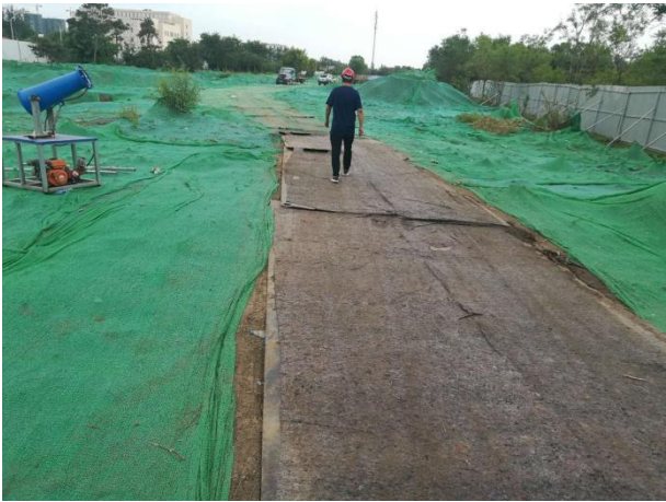
图 7-6 施工期场地内运输路面铺设钢板照片
