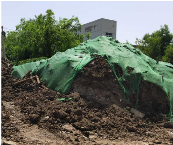
图 7-2 施工期工程渣土集中堆放苫盖照片
