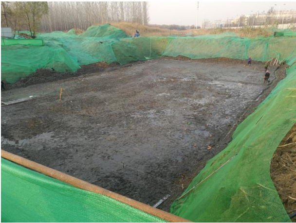
图 7-4 施工期土壤裸露部分苫盖照片
