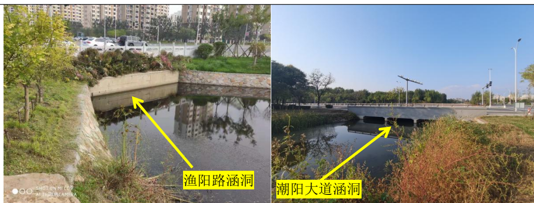
图 4-3 渔阳路涵洞、潮阳大道涵洞现状图
