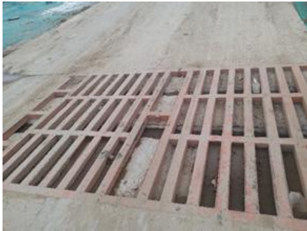
图 4-17 施工期沉淀池照片
